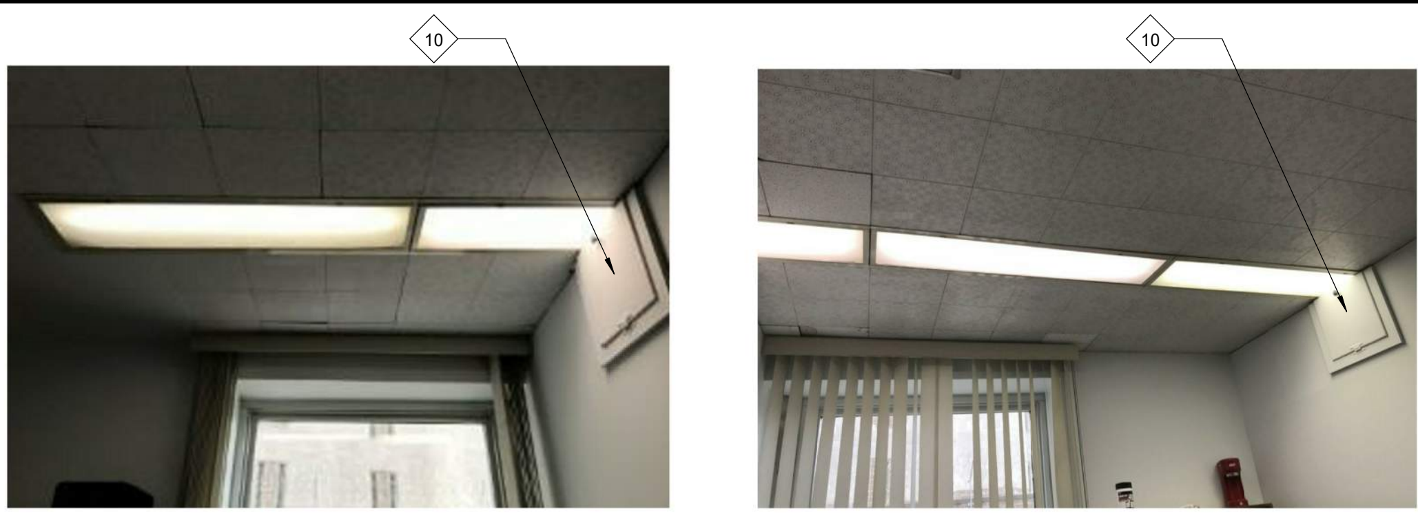
2 FIXTURE ACCESS DOOR PHOTOS SCALE: N.T.S.
